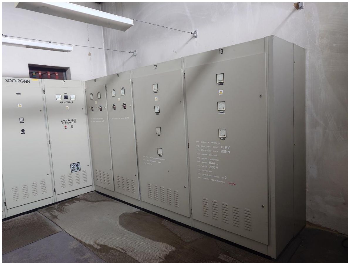
Rozdzielnia sekcji drugiej NN moc umowna przyłącza - 250 kW
