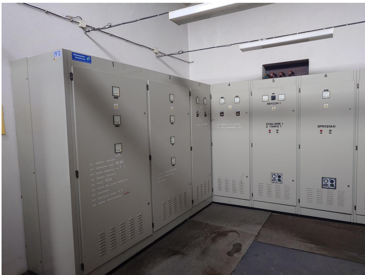
Rozdzielnia sekcji pierwszej NN moc umowna przyłącza - 460 kW
